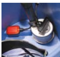
équipé de pompe submersible
