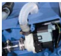
équipé de pompe de vidange
